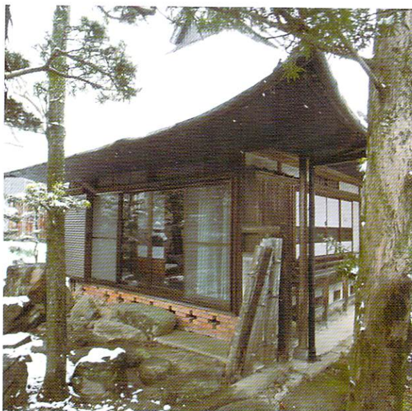
36 座敷南東隅に残る袖壁
